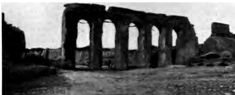
Fig. 165. — RUINES D'UN AQUEDUC Franchissant le lit de l'Oued Ouar.
