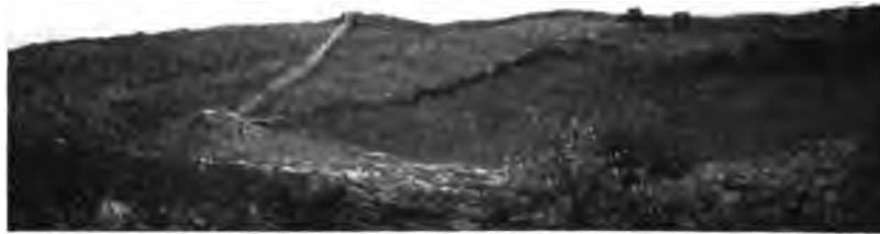
Fig. 59. — QAÇBA DE ZERHOUN (Az. = 180°). Ruines de l'enceinte fortifiée.
